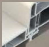
Pose de la pièce d'appui rapportée réalisée en atelier
